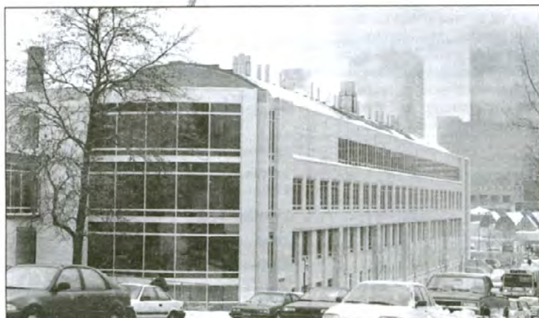
Le nouveau pavillon de chimie et de biochimie, rue Jeanne-Mance, devrait accueillir ses futurs occupants fin février ou début mars.
