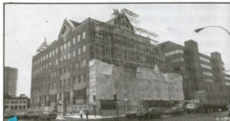
Le bloc « W » en voie d'être complété.
