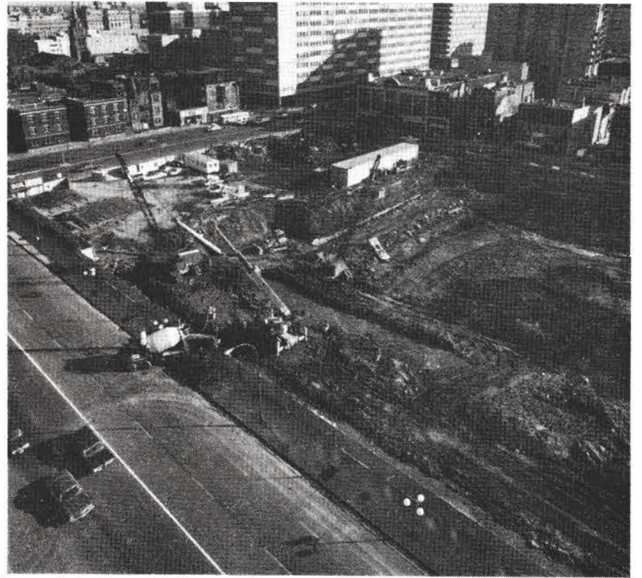
Vue partielle du quadrilatère sud. Au premier plan, la rue Berri. Au bord de l'excavation, l'usine de bentonite (petit bâtiment blanc) et derrière, l'angle du boul. Dorchester et de la rue Saint-Denis.
