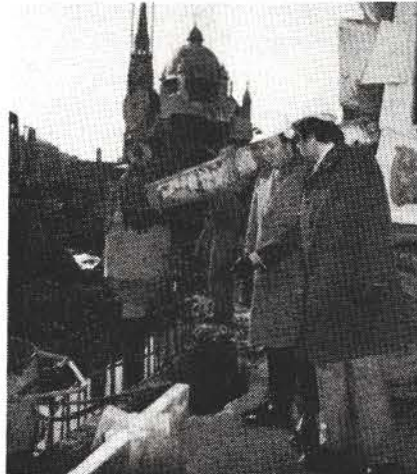
On coule le béton dans les tranchées des parois moulées à l'aide d'une "trompe d'éléphant".
