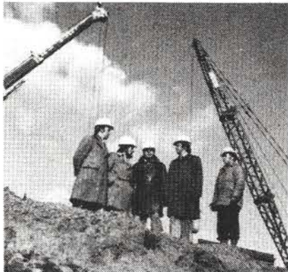
Dans l'ordre, le recteur de l'UQAM, M. MAURICE BROSSARD; le coordonnateur du projet, M. BERNARD LANGLOIS; le directeur du chantier, M. MARCEL AUBRY; le directeur général de la construction, M. ANDRÉ ROBILLARD, ingénieur; le surintendant, M. RAYMOND VIGER.
